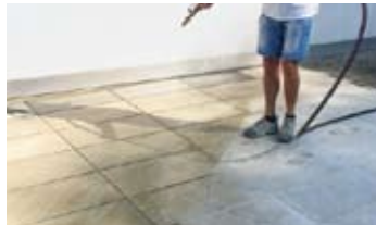
4 Bagnare la superficie con acqua
